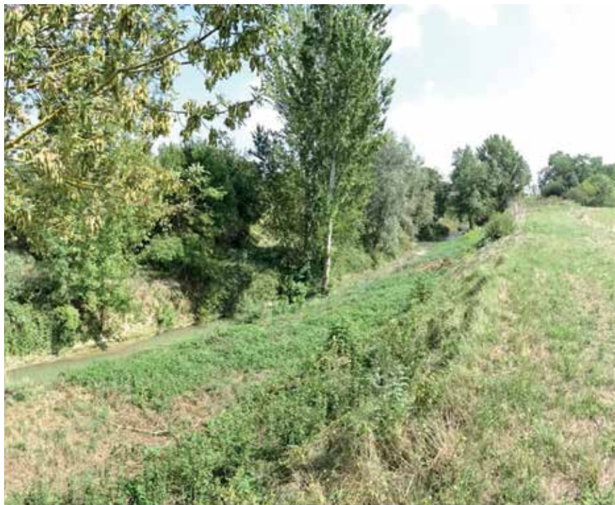
Confluence Hers-Maury (avant travaux 2018)
