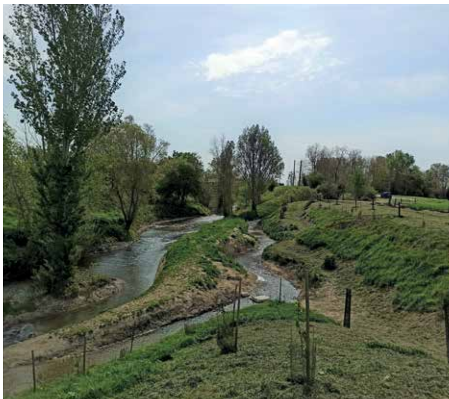
Confluence Hers-Maury (après travaux 2021)
