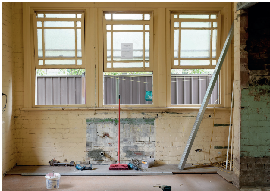
Intérieur en cours de rénovation
