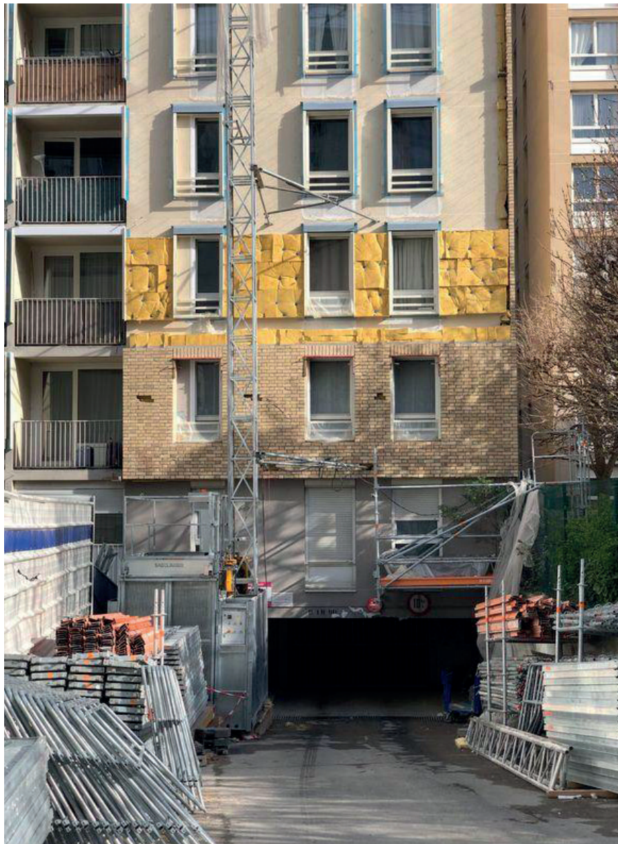
Façade d'une copropriété en rénovation (isolation par l'extérieur)
