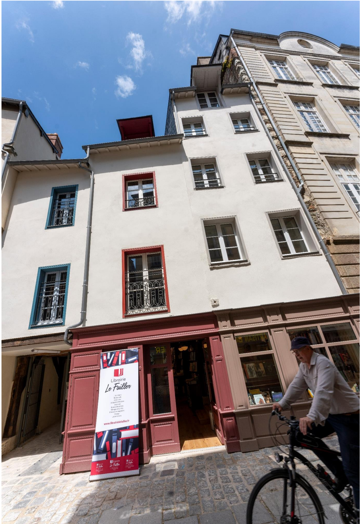
RÉNOVATION DANS CENTRE ANCIEN, 9 RUE SAINT-GEORGES À RENNES © Arnaud Louby / Rennes Ville et Métropole
