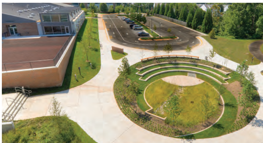
Les eaux des toitures et des parkings sont traités par le jardin de biorétention
