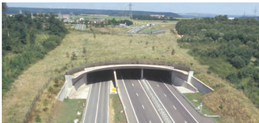
Exemple de franchissement écologique en Suisse sur l'autoroute du Nord - A7 « Roost »
