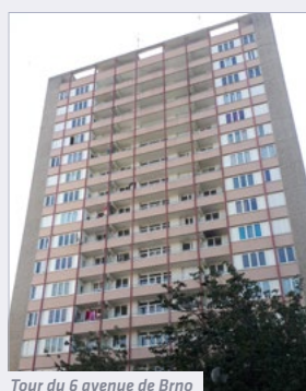
Tour du 6 avenue de Brno
