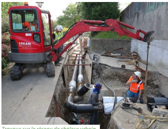
Travaux sur le réseau de chaleur urbain.
