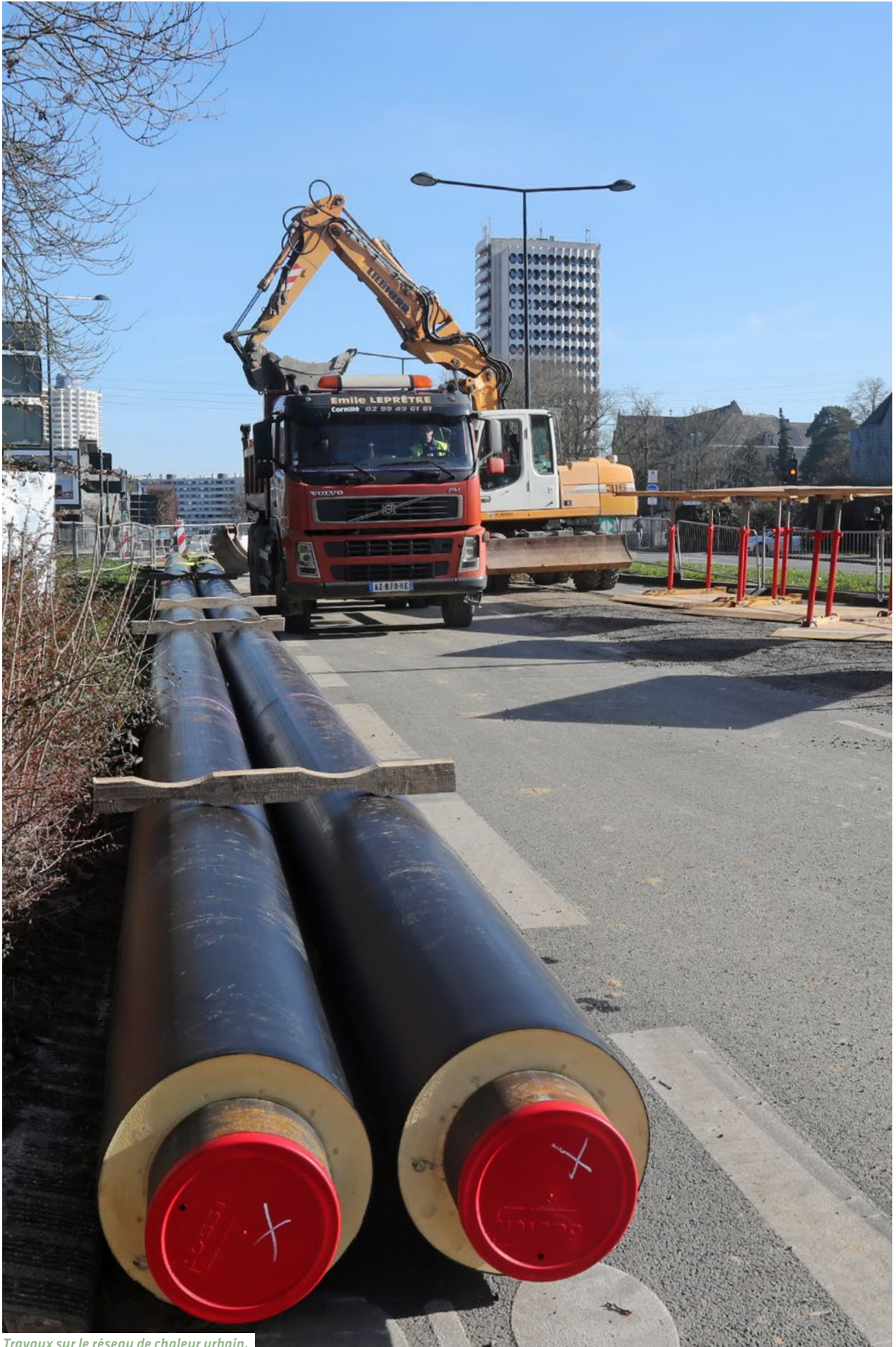
Travaux sur le réseau de chaleur urbain.
