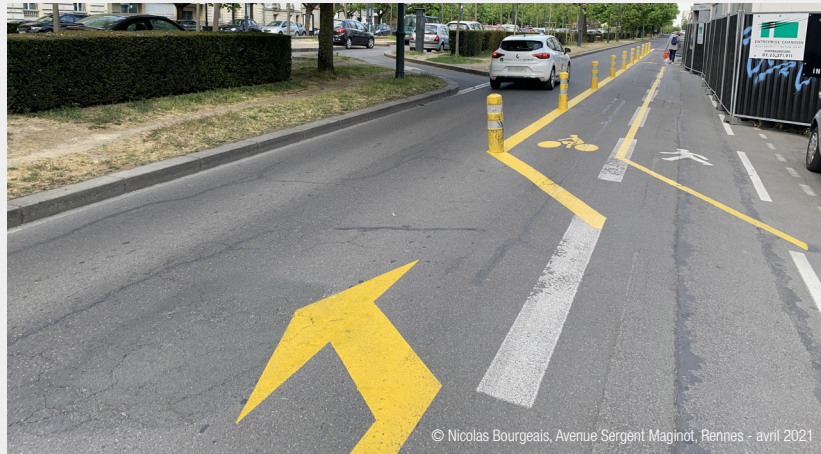
Aménagement tactique à Rennes pour sécuriser les piétons et cyclistes avec la neutralisation par l'emprise d'un chantier du trottoir et de la bande cyclable. Rennes - avril 2021.
